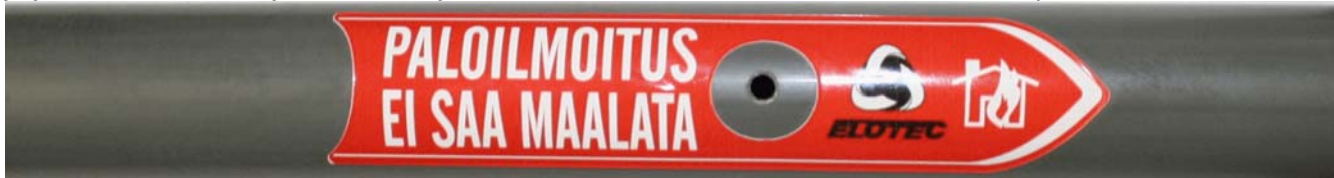
Oikein merkattu putki. ASPECT oikealla.
